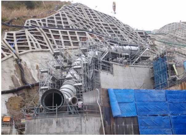
利水放流管（下流より全景）
