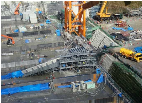
常用洪水吐き放流管（左岸より）
