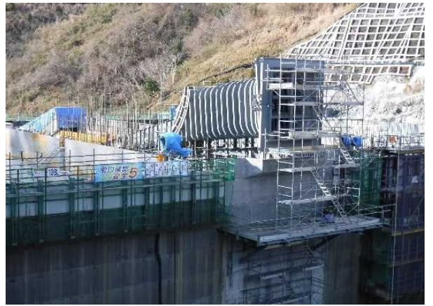
常用洪水吐き放流管（上流面より）
